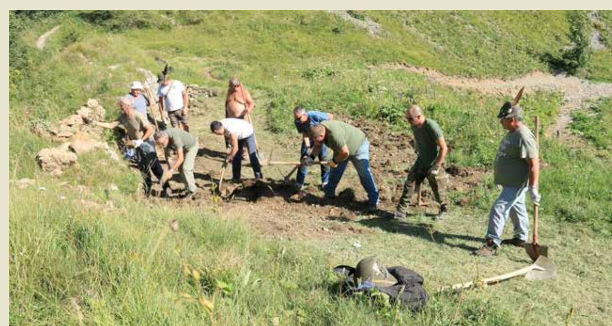
Figura 4 - Lavori di ripristino
